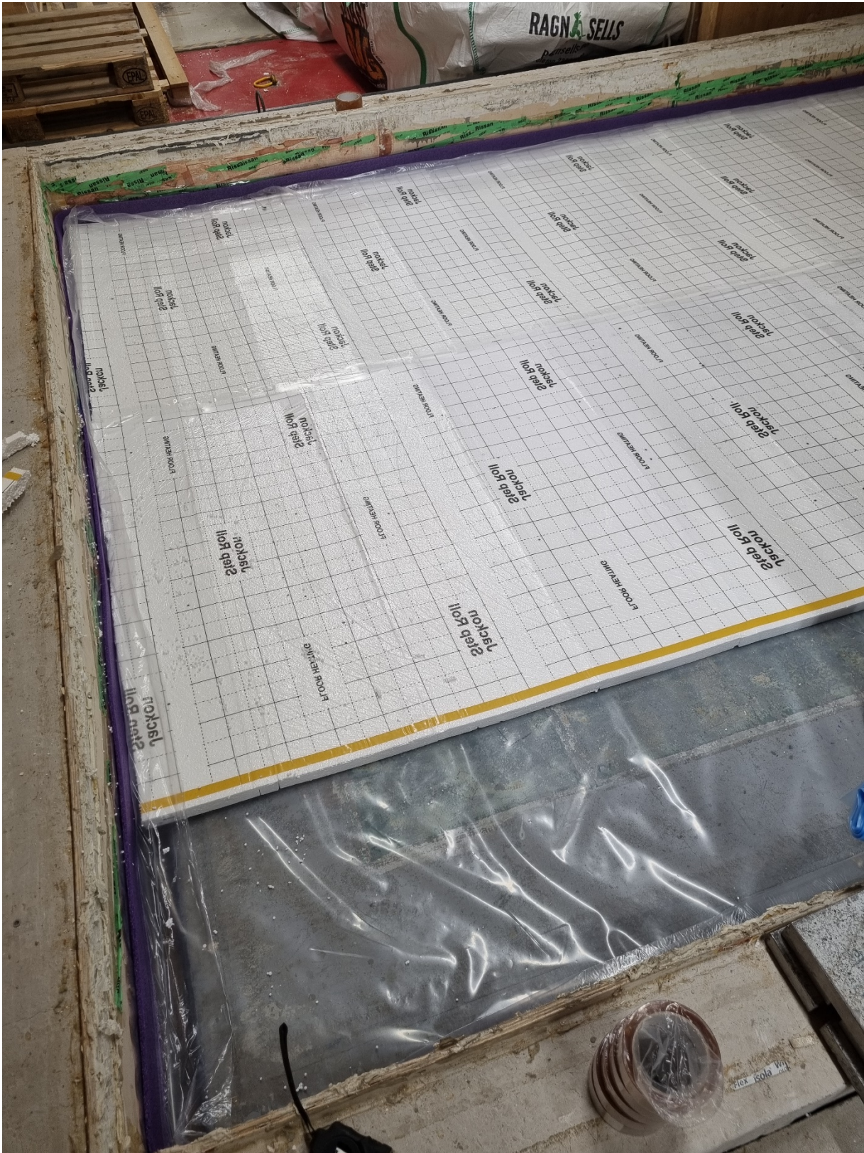
Figur A.1: Prøveoppsett under bygging
