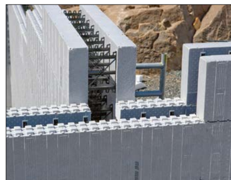
Moderne grunnmur av fullisolerte forskalingsblokker: Thermomur®
