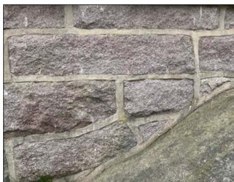
Eldre grunnmur bygget opp av naturstein
