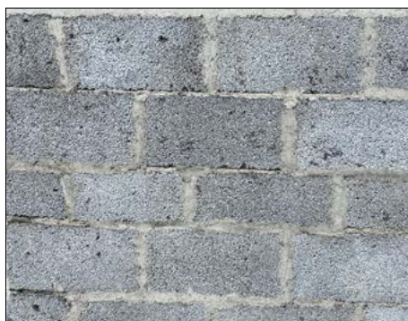
Eldre grunnmur bygget opp av lettklinker
